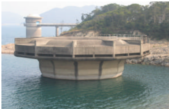
鐘型虹吸溢洪道
